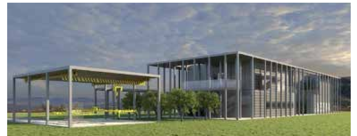
Το Τεχνικό Εκπαιδευτικό Κέντρο στη Νέα Μεσημβρία
