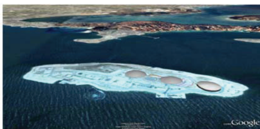
Εικόνα 1: Εναέρια προσεγγιστική όψη τερματικού σταθμού νήσου Ρεβυθούσας με την εγκατάσταση της 3 ης δεξαμενής.
