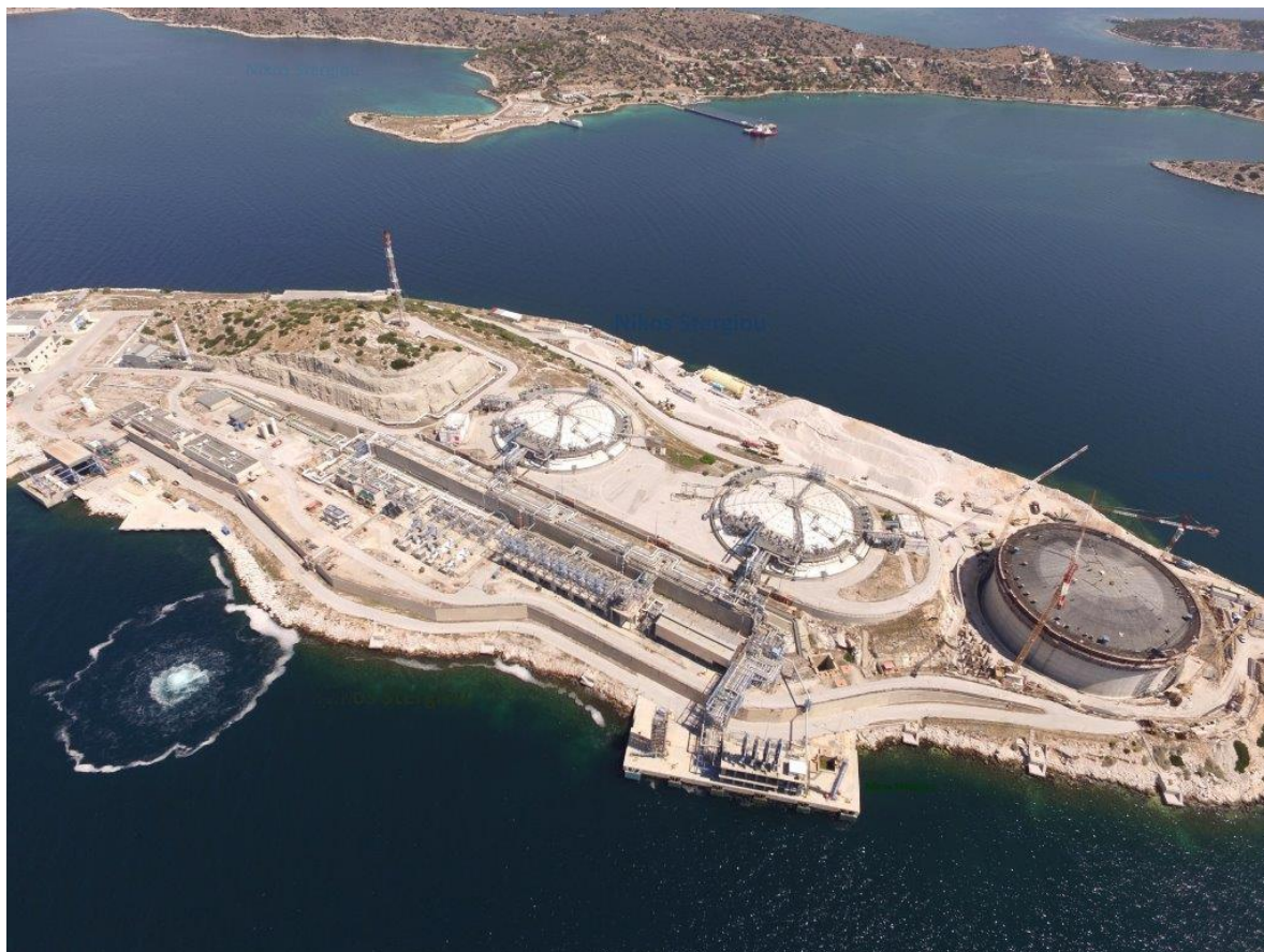
Εικόνα 2: Εναέρια προσεγγιστική όψη τερματικού σταθμού νήσου Ρεβθούσας με την εγκατάσταση της 3 ης δεξαμενής.
